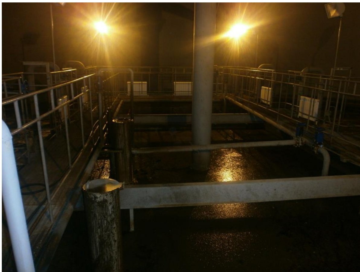
Рисунок 4. Аэротенк на КОС 18 000 м 3 /сут.
