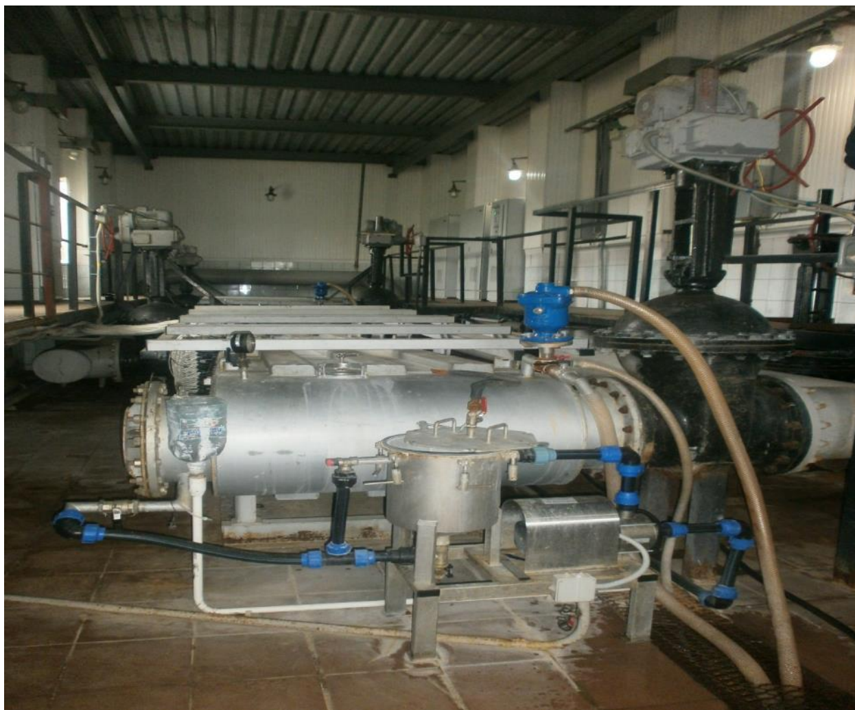
Рисунок 9. УФ-установка на КОС 18 000 м 3 /сут.
