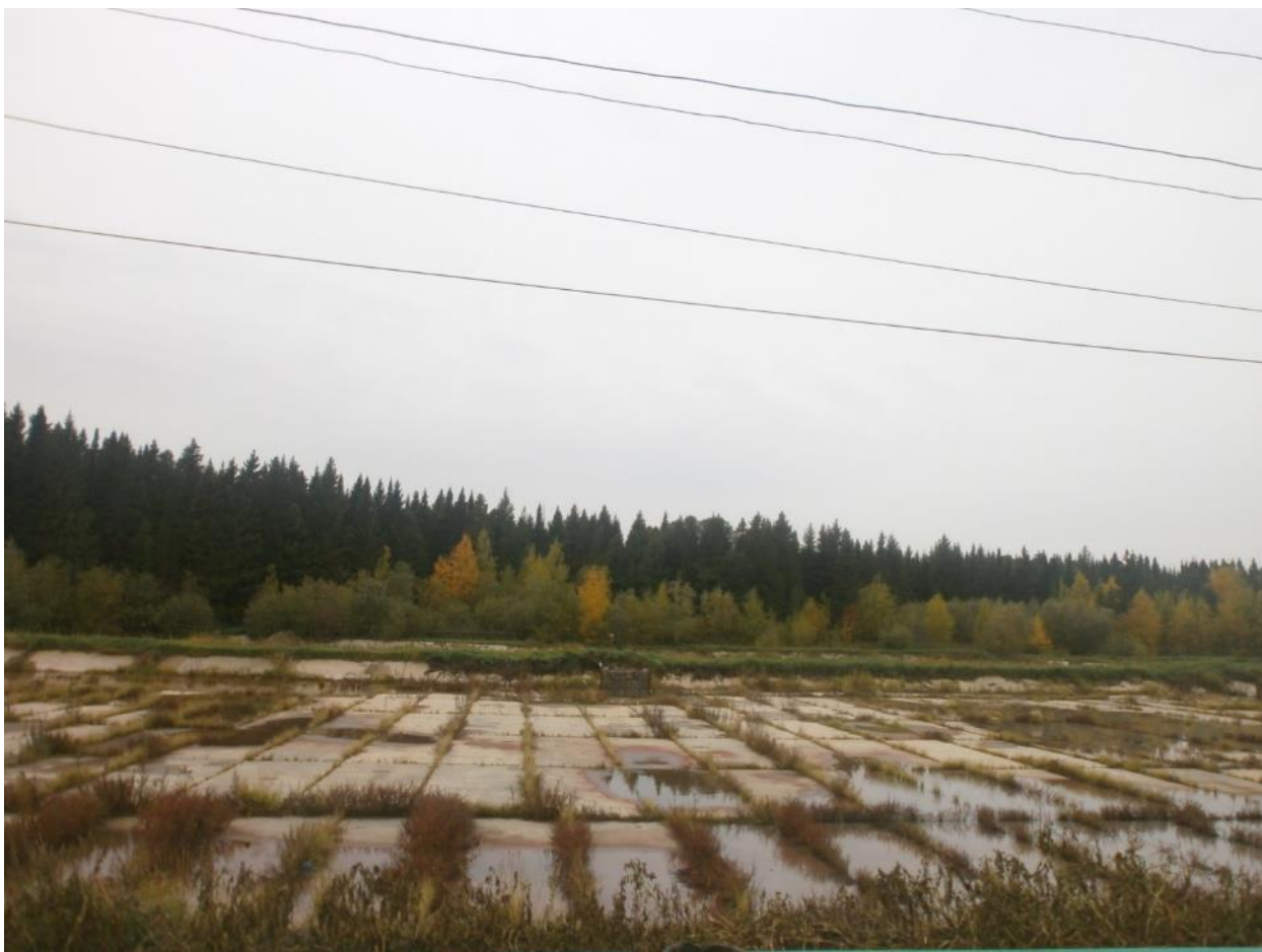
Рисунок 14. Поля компостирования на КОС 18 000 м 3 /сут.
