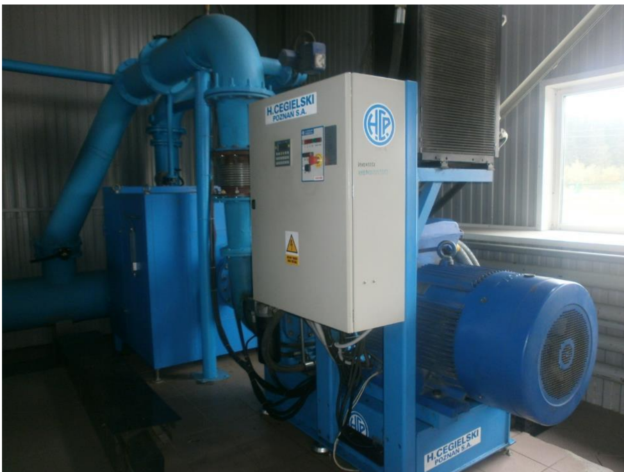
Рисунок 15. Воздуходувки на КОС 18 000 м 3 /сут.
