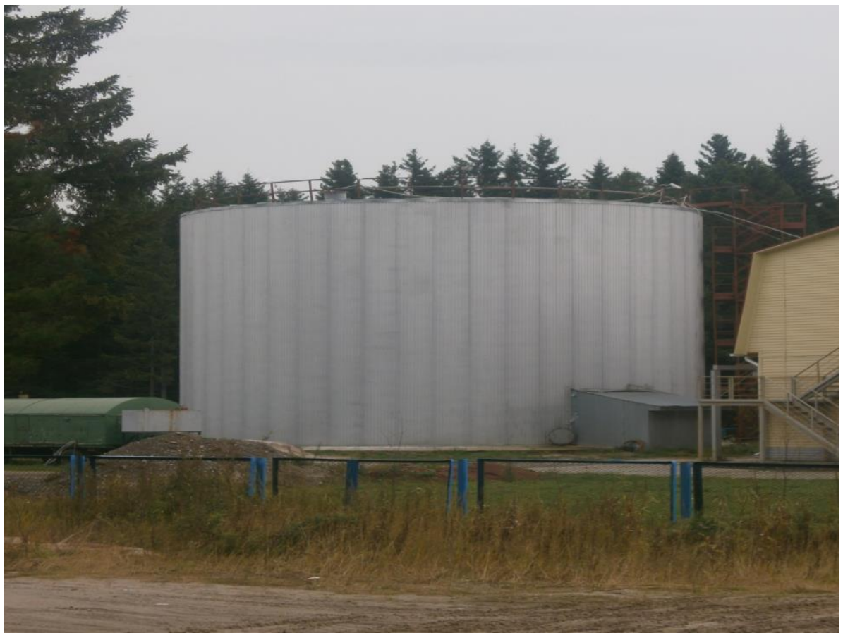
Рисунок 18. Усреднительная емкость на ГКНС
