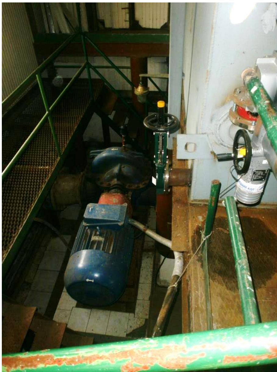
Рисунок 7. Насосы промывки фильтров на КОС 18 000 м 3 /сут.
