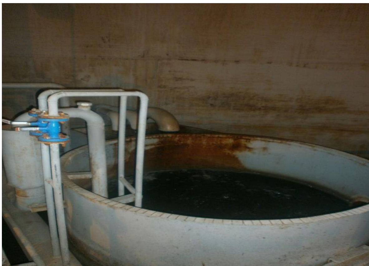
Рисунок 3. Песколовки на КОС 18 000 м 3 /сут.
